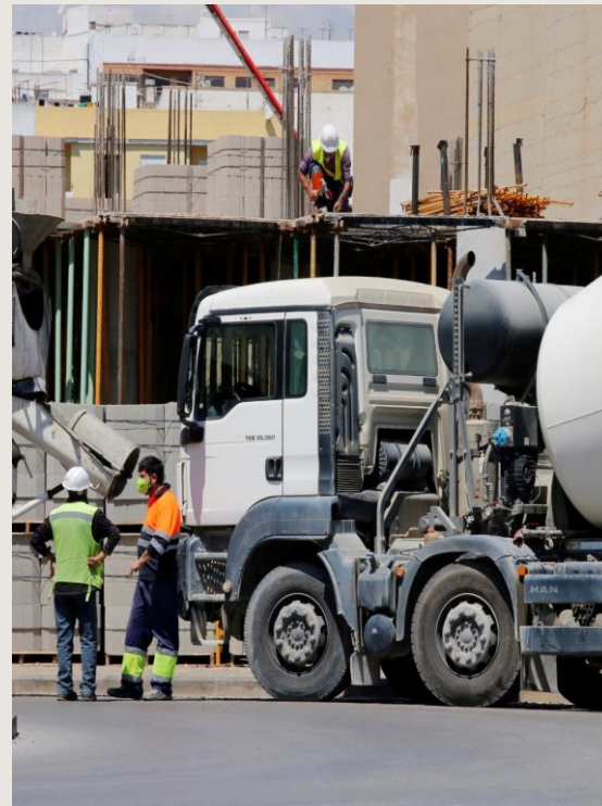
Obreros esperando a que termine de mezclar el camión
