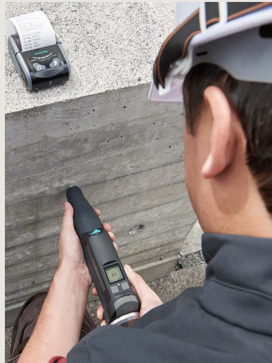
Evaluación de la Resistencia y Uniformidad del hormigón
