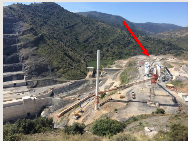
Planta de Hormigón CAES con 4 Mezcladoras, para producción de 500m 3 /h en continuo 24/7, fabricando HRC hormigón seco compactado con rodillos y dosificando sobre cintas transp. rotec con descarga directamente al cuerpo de la presa
