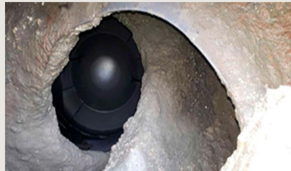
Dosificado en Vía Seca
