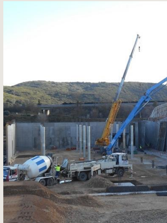
Camión hormigonera suministrando a bomba de hormigón
