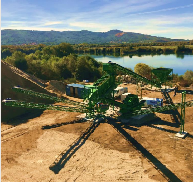
Planta de lavado de áridos CAES-CONSTMACH
