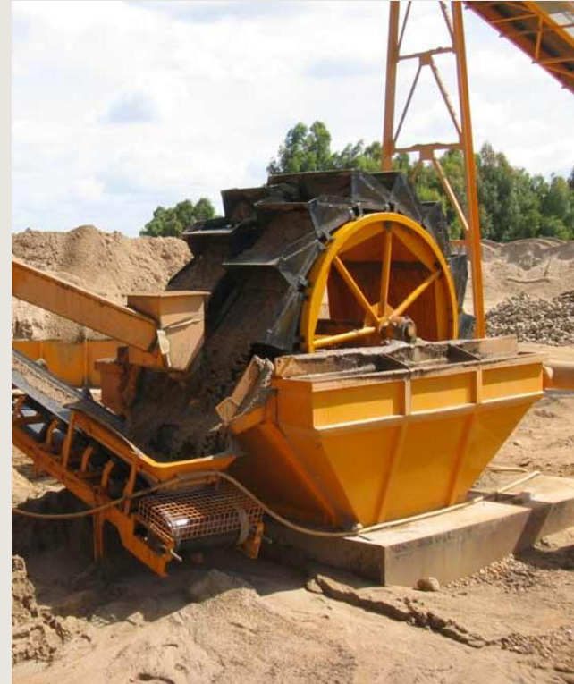
Noria decantadora en planta CAES-CONSTMACH
