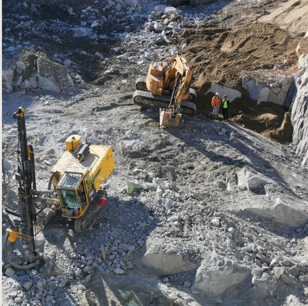
Equipos de perforación y extracción en cantera
