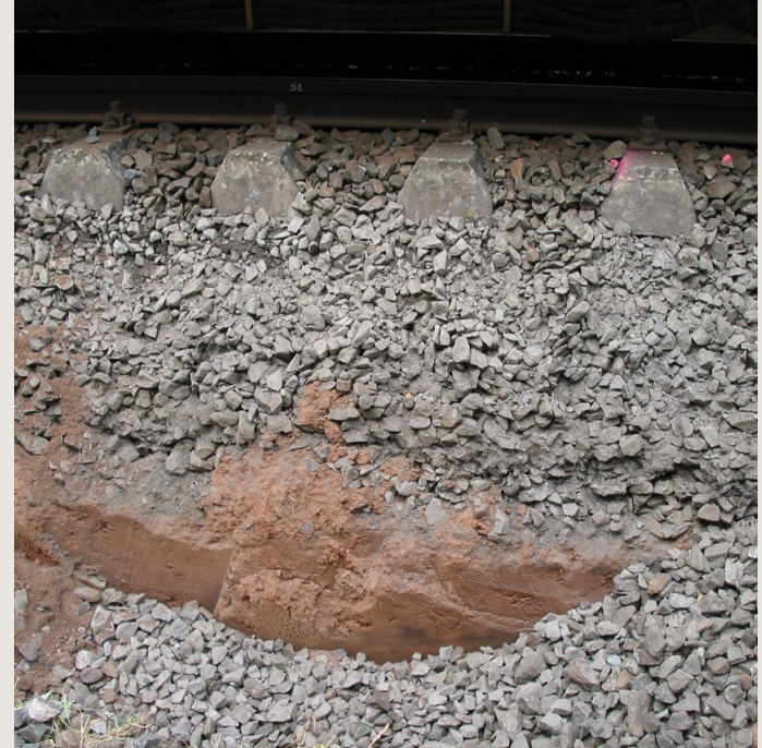
Capa de base de balasto sobre plataforma
