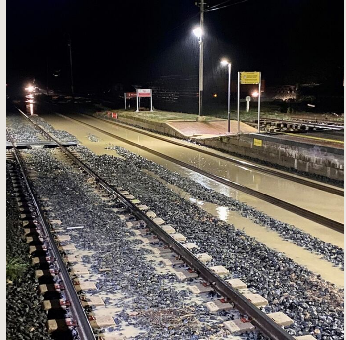
Línea férrea inundada
