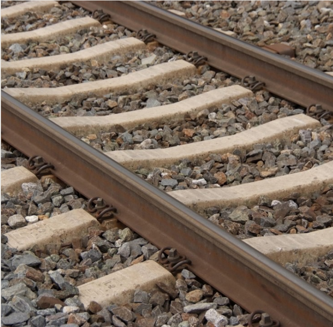
Lecho de balasto formando la vía férrea
