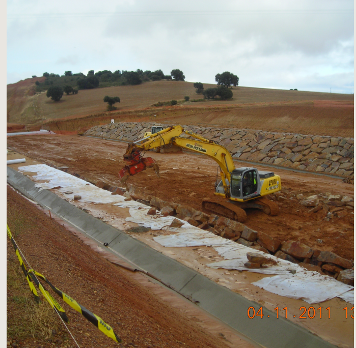
Instalación de geotextil en plataforma de baja calidad
