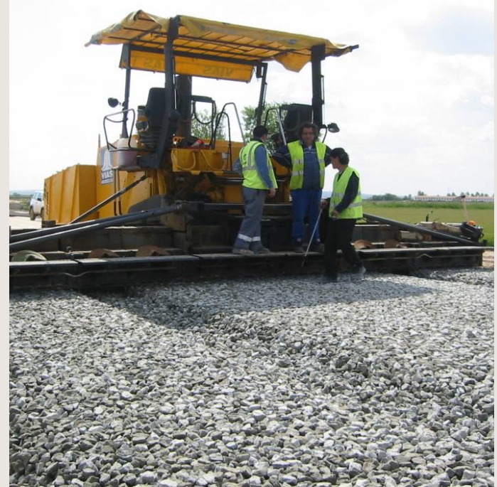
Extendedora aplicando base de lecho de balasto
