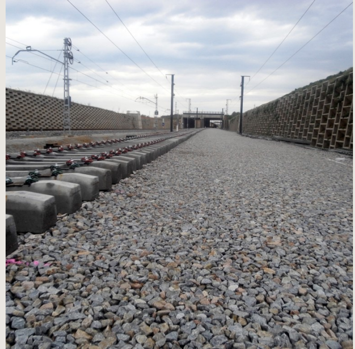
Plataforma para sustitución de traviesas
