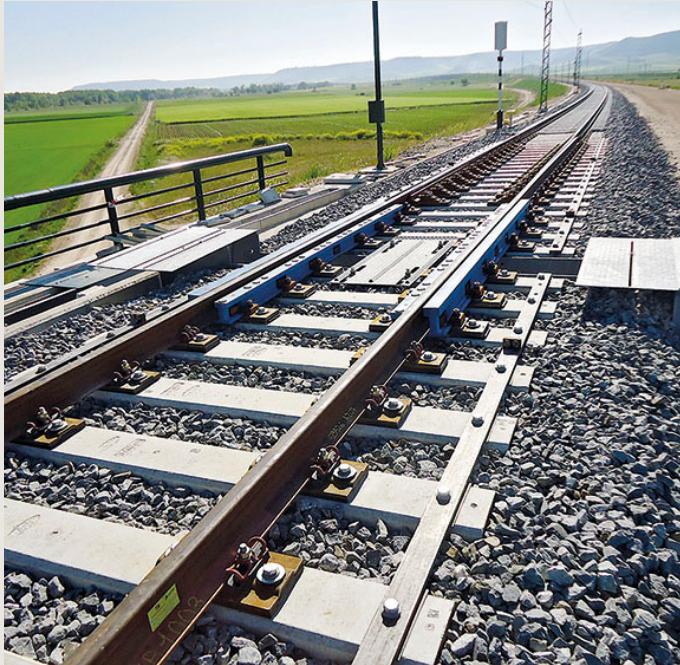
Vías férreas sobre lecho de balasto
